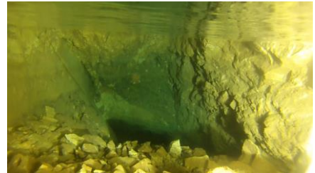
Pohľad do výveru pod hladinou (rez A1)
